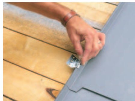
Ausrichten des Elements und Fixieren mit Plattenhaft
