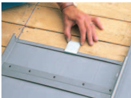
Montage der Edelstahl-Clips (Systembestandteil)
