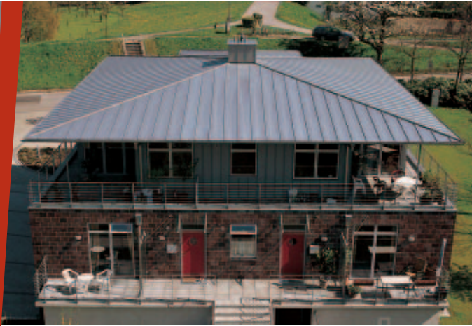
Unbelüftete Dachkonstruktion
